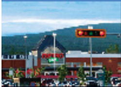
Carrefour St. David Avenue St. David Ouest & rue Clemenceau, Québec City
